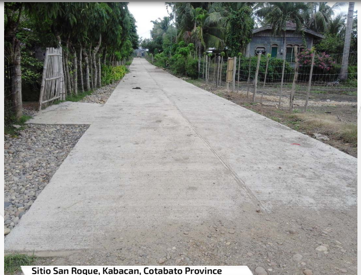
Sitio San Roque, Kabacan, Cotabato Province Concreting of Sitio San Roque - Sangadong
